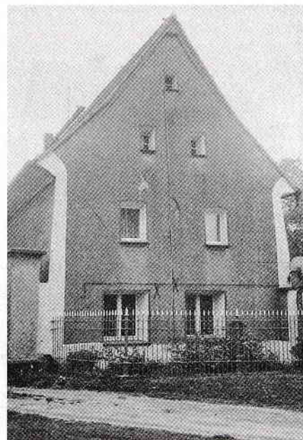
Fig. 1.2-8 Rezință în Gottscheina, 1768, construcție cu tencuială de lut
